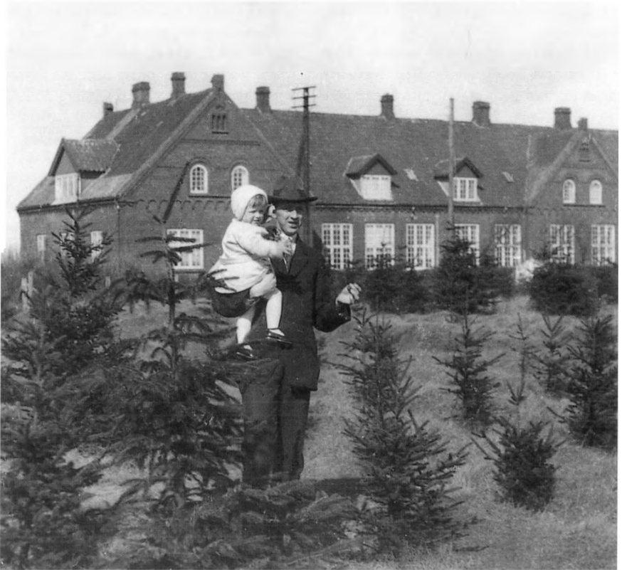
Forfatteren med sin far ca. 1929. De fleste skorstene på skolen var til ventilation. Den store til venstre hørte til centralvarmeanlægget.
