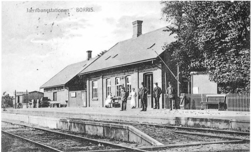
Borris Station i begyndelsen af vort århundrede. Postkort sendt i september 1914. (Borris lokalhistoriske Arkiv).
