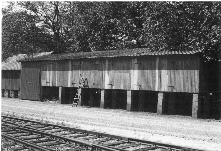
Pakhus ved Borris Station, opført omkring 1900 og hele tiden brugt af tømmerhandler Jepsen, der betalte leje af grunden. 1998. (Foto Ove N. Enevoldsen).
