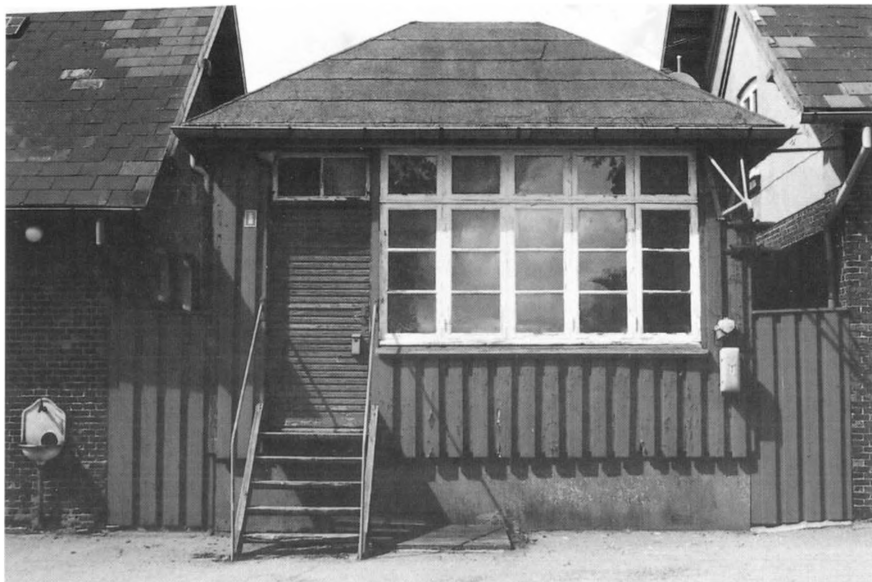
Signalhuset ved Borris Station, hvorfra armsignalet styres, 1998. Huset er bygget omkring 1920. (Foto Ove N. Enevoldsen).
