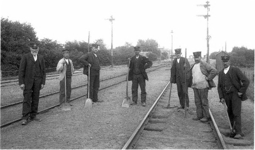
Banekolonnen på arbejde i Herning stations vestende. Signalerne i baggrunden er udkørselssignalerne mod henholdsvis Holstebro og Skjern. (Lokalhistorisk Arkiv, Herning)
