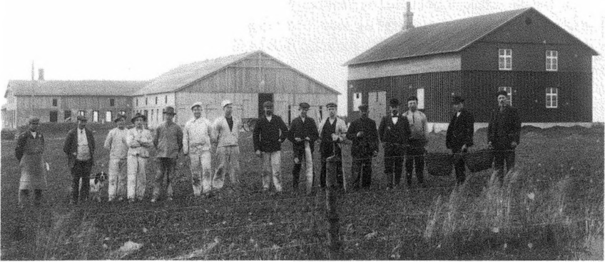
Håndværkere og forsøgsfolk opstillet foran byggeriet i 1909. Far står som nummer to fra højre. Til højre ses den færdige forsøgslade og til venstre avlsbygningerne under opførelse. Længen nærmest er hestestald og lade, længen vinkelret herpå er kostald og karlekamre, og længen der forsvinder bagud i billedet er svinestald. Avlsbygningernes form ses bedre på luftfotoet fra 1935 senere i artiklen.
