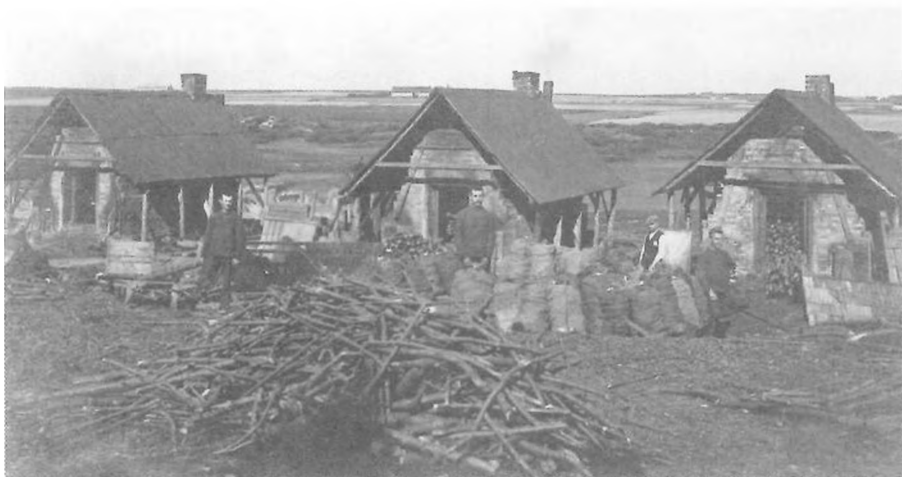
Tjærebrænding i Harreskov plantage 1902. Det Classenske Fideicommis ydede bidrag til opførelse af ovne til forsøg med fremstilling af trægas, træsyre og tjære. Den brune montanajtjære fra Hareskoven fik mange anbefalinger, og det var en erfaring, at trækul holdt fordøjelsen i orden hos høns og smågrise.
