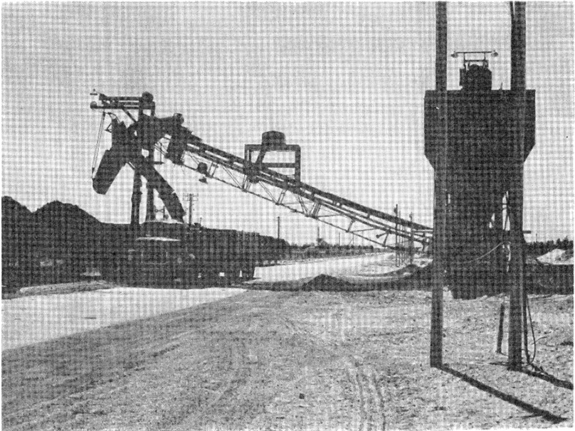
Teknikken har sejret. El- og bøjspændingsmaster præger landskabet i Søby. Fra det lange transportbånd (forsidebilledet) føres kullene op i siloen, hvorfra der sker automatisk afvejning i lastbil og jernbanevogn, som fragter brunkullene til Vestkraft i Esbjerg.
