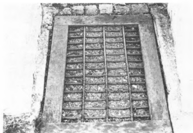
Ved indgangene til Stauning Kirke er der tre riste i egetræsrammer. Foto: Ulrik Schrøder.
