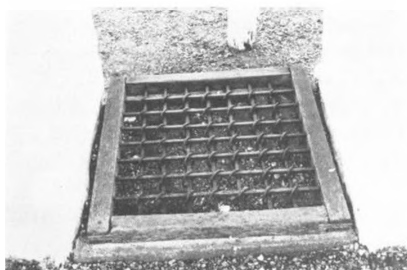
I Nørre Bork er jernstængerne »bundets« sammen med ringe. Ristene ligger i solide egetræsrammer, der er samlet med nagler i hjørnerne. Foto: Ulrik Schrøder.
