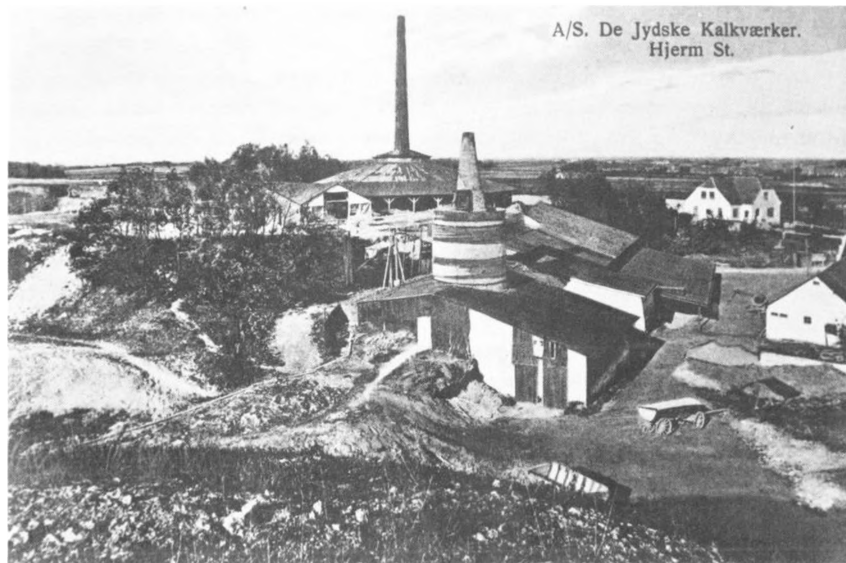
Kalkværket. Den store ringovn ses i baggrunden, midt i billedet. Firmaet løb gennem årene ind i mange tekniske vanskeligheder i Hjerm, primært fordi kalken var meget vandholdig og krævede høje varmegrader i brændingen. (Foto: Lokalhistorisk arkiv for Struer Kommune)
