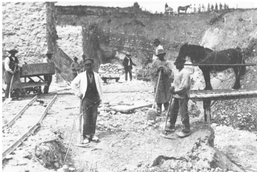
Kalkværksarbejdere i den åbne grav. Fra 1893 var man desuden begyndt at hente kalken i underjordiske gruber. I gruberne kunne der hugges og lagres kalk om vinteren, når frosten standsede arbejdet i den åbne grav. (Foto: Lokalhistorisk arkiv for Struer Kommune)
