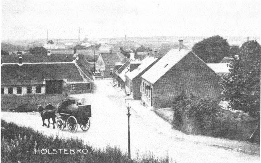
Parti fra den lille »slippe« Ablgade, da den hed Enghavegade. Til venstre Nybos gård. Foto: Lokalhistorisk Arkiv for Holstebro Kommune.
