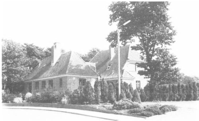
Vind station er velbevaret, men har ubeldigvis fået vinduernes træværk malet brunt i stedet for hvidt. Foto: Nina Dahlmann Olsen.
