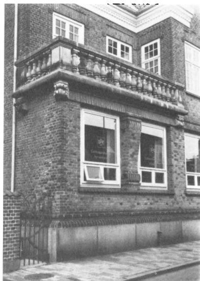
Den ene af de to balkoner med balustre, der flankerer midterpartiet af Sparekasse-bygningen. Foto: Nina Dahlmann Olsen.
