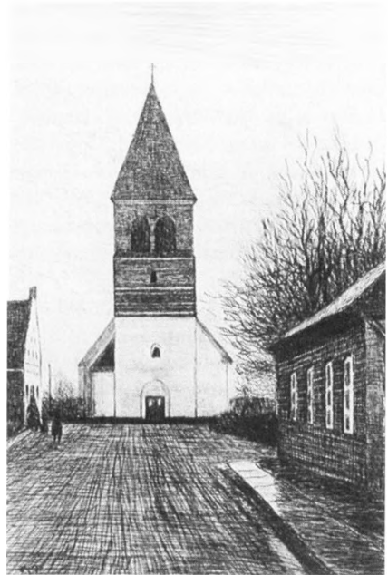
Tarm kirke. Til venstre ses gavlen af det missionshus, som kirkekomiteen måtte opføre til erstatning for det missionshus, der blev nedrevet for at give plads for kirken. Det er senere igen fjernet for at give plads for sygehusets parkeringsplads. Tegning 1933.
