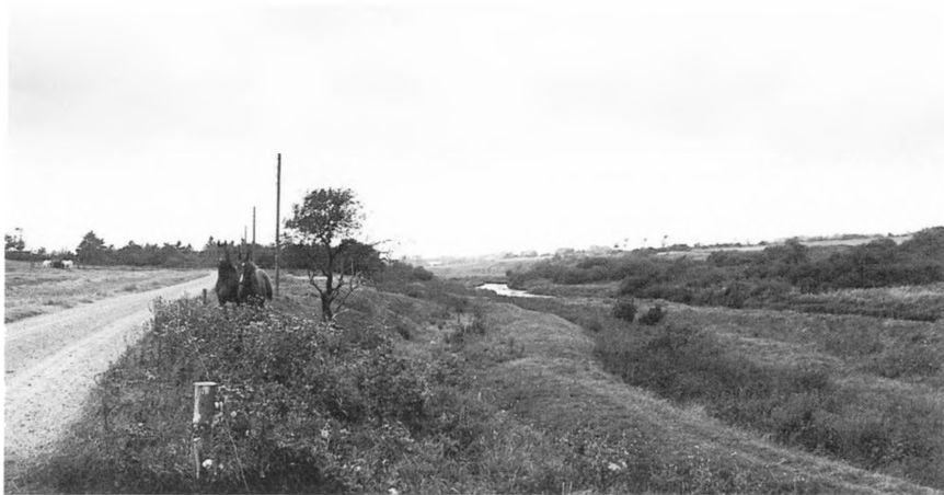
Engvandingskanal på sydsiden af Hover Å, anlagt 1869-70. Dæmningen løber til højre for vejen. (Foto: Birger Knudsen, Ringkøbing Museum).
