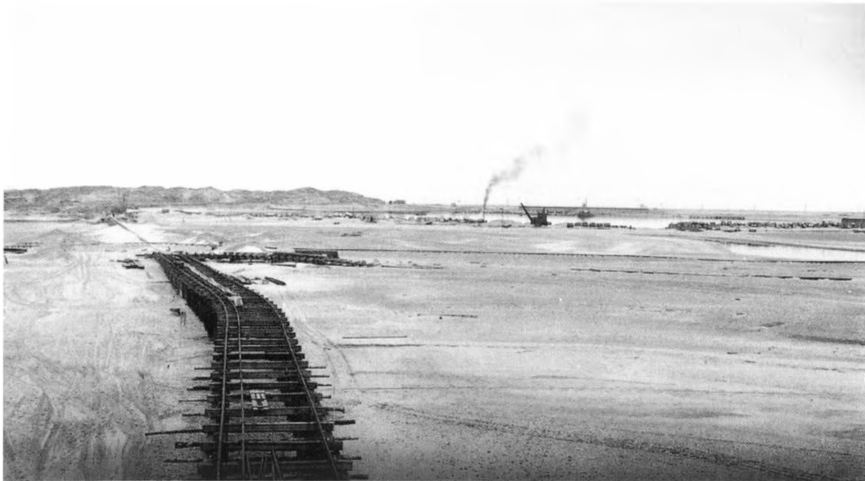
Nordmolen føres ud over stranden. Kranen arbejder ved gennembrydningen af den gamle sikringsmole. I baggrunden Troldebjergklitterne og afvandingslusen. (A. Grimstrup)
