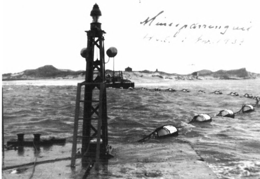
Minespærringen. Et udspændt net skal forhindre miner i at drive mod sluseanlægget.
