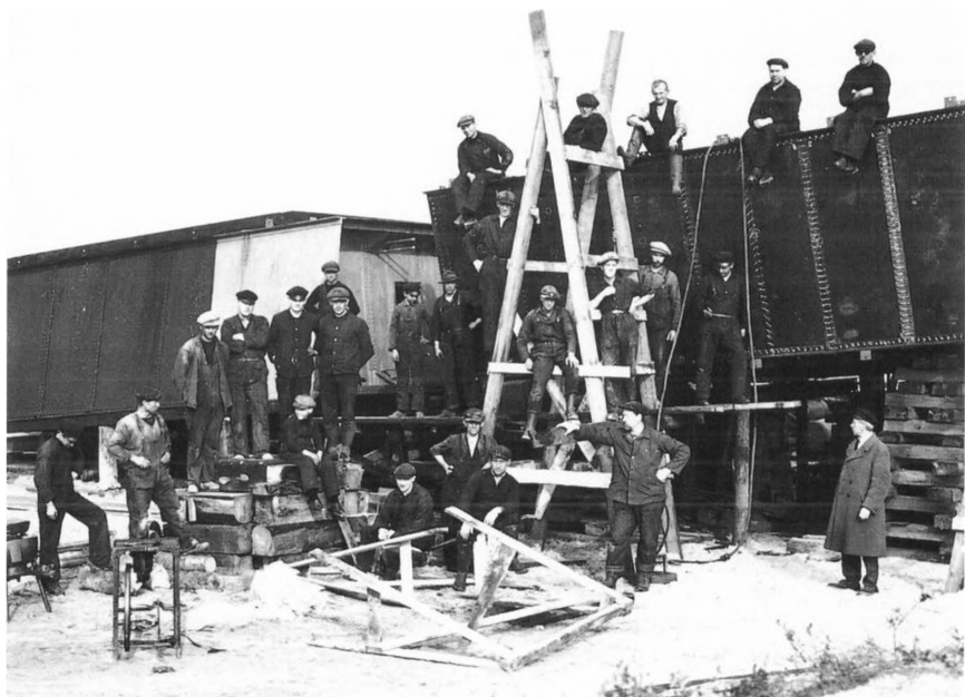
Arbejdsstyrken. Smede. Kammerslusens skydeporte af pladejern bygges på stedet. (A. Grimstrup)
