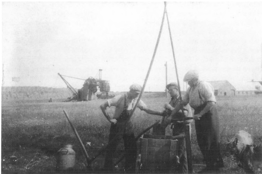
Der borer i Ejstrup lejet. Til højre boremester Jens Peder Pedersen (Skygge), der vrikker med boret, til venstre hans søn Johannes Pedersen, manden i midten er ukendt. De to sidste vrikker med pumpen. I baggrunden en spandgravemaskine, der graver overjord af, som hældes i tipvogne og køres væk. Ved boring ved et kulleje var meningen at kortlægge kullagets udstrækning.
