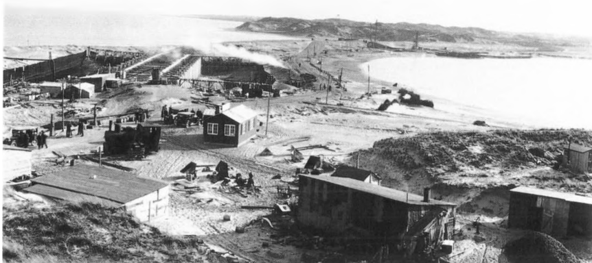
Byggepladsen set fra Troldbjerg. Slusekamrene er ført op til færdig højde. I baggrunden kammer-slusen. (A. Grimstrup)
