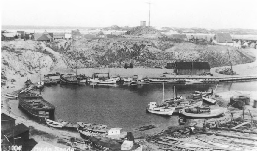
Mamrelund. Nok det mest fotograferede motiv i byns første årtier. Her ses til højre lidt af beddingsløbet. I midten rager vandtårnsbakken op, og bagved ses tagene af de nye fine stenhus.
