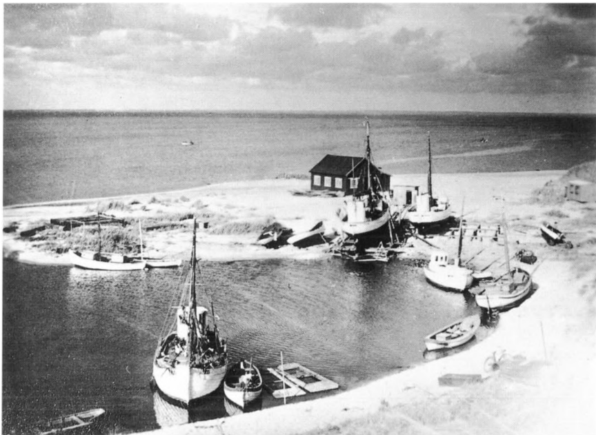
Skibstørrer Jens Chr. Poulsen, Lemvig, anlægger ophalerbedding øst for Mamrelund i 1933. Strømmen går for hårdt mod kysten, og beddingsløbet må i 1935 flyttes ind i roligt vand i Mamrelund-bassinet. Kontrakten overgår senere til skibsbygger Johs. Kristensen.
