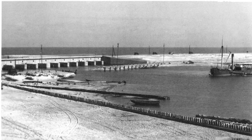
»Nymindegab« uddyber vest for den særdige sluse. Den midlertidige landevej foran slusen pumpes væk. (H. Pors)
