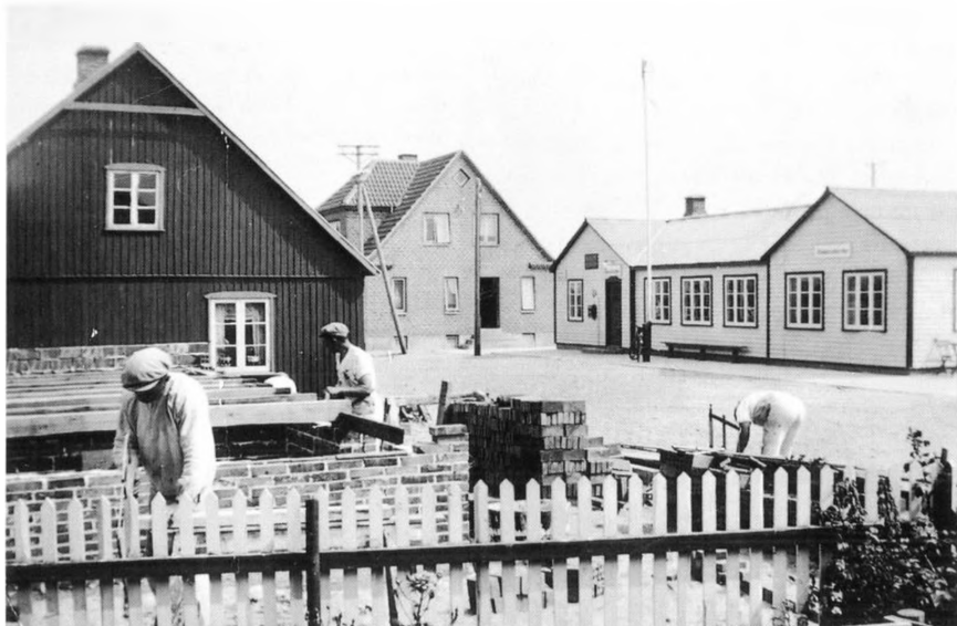
Murermester Anders Kusk Christensen opfører hus til malermester Niels Enevoldsen i Bredgade o. 1939. I baggrunden sømandshjemmet og den nyopførte telefoncentral tilhørende Thyge Vembs døtre Jensine og Nielsine Nielsen (Restaurant Slusen). Det mørke træhus tømrer og glarmester Jens Jensen.
