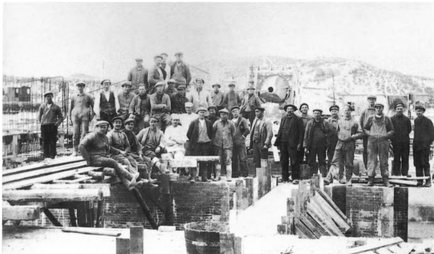
Arbejdsstyrken. Arbejds­mænd og murere. Slusens piller føres op som en skal af murværk, hvorefter kærnen fyldes med beton. I baggrunden anes Troldebjerg.
