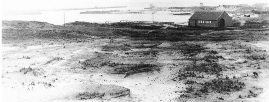
Ny redningsstation fra 1933. I baggrunden ses åbningen i den gamle sikringsmole og længst ude de to nye ledemoler ved indsejlingen. (A. Grimstrup)
