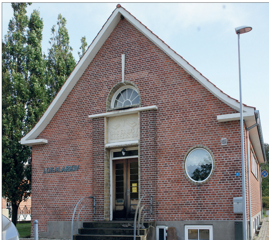
Vinderup Egnshistoriske Arkiv har til huse i denne bygning, der tidligere var bibliotek i Vinderup.
